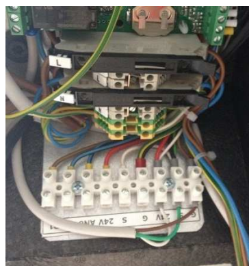
Collegamento elettrico pannello di comando E all'unità
